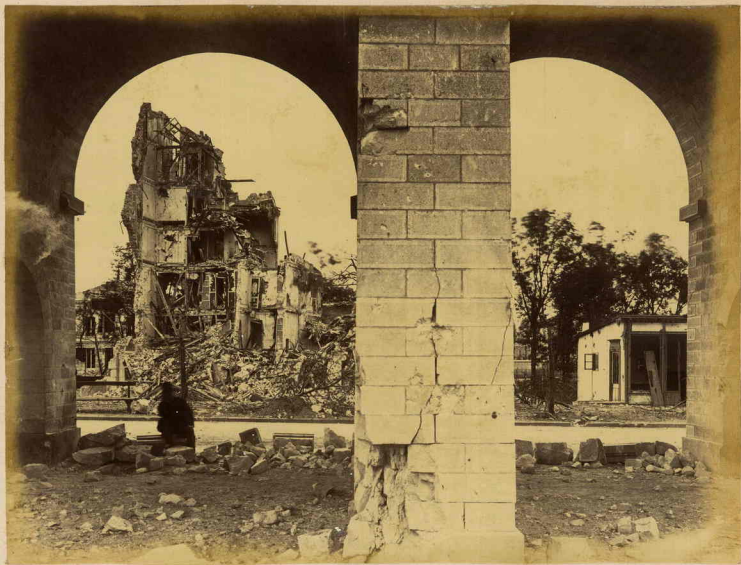
64 Écluse du pont viaduc d'Anteuil.
