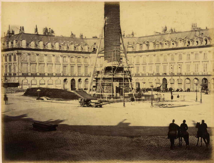
27 Place Vendôme. Elevation de la Colonne ; derniers préparatifs.
