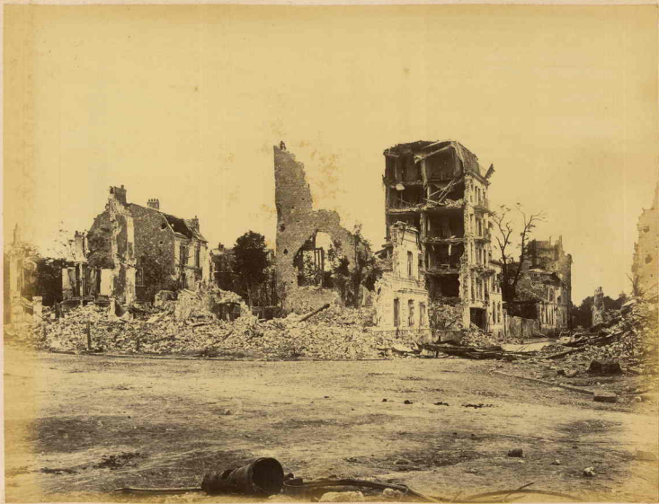
62 Ruines près du pont et de la gare d'Autenil.
